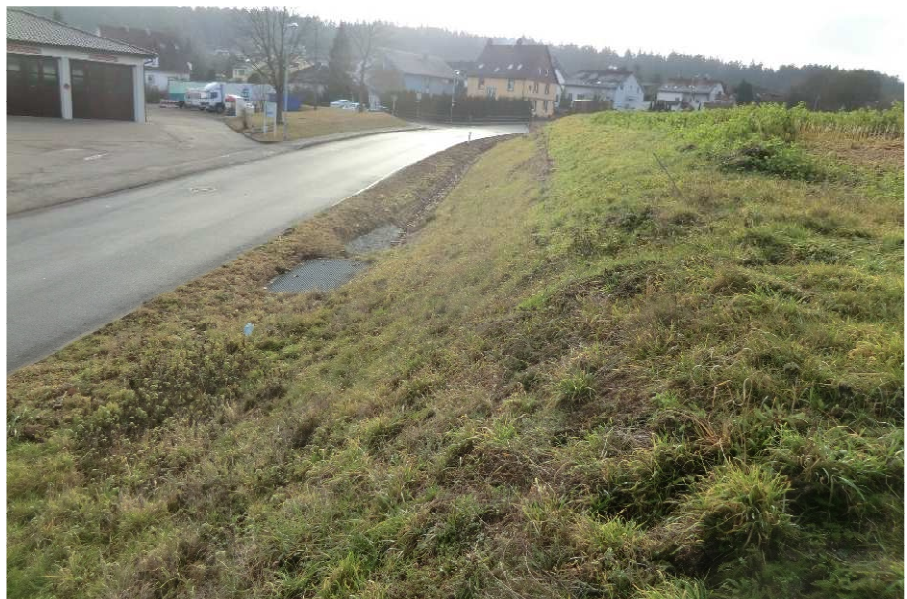
Foto 5 Böschung an der Calwer Straße (28.12.2016).
