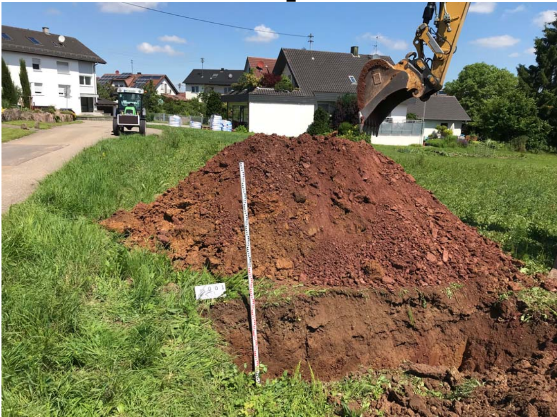
Fotodokumentation Baggerschürfe am 17.06.2019
